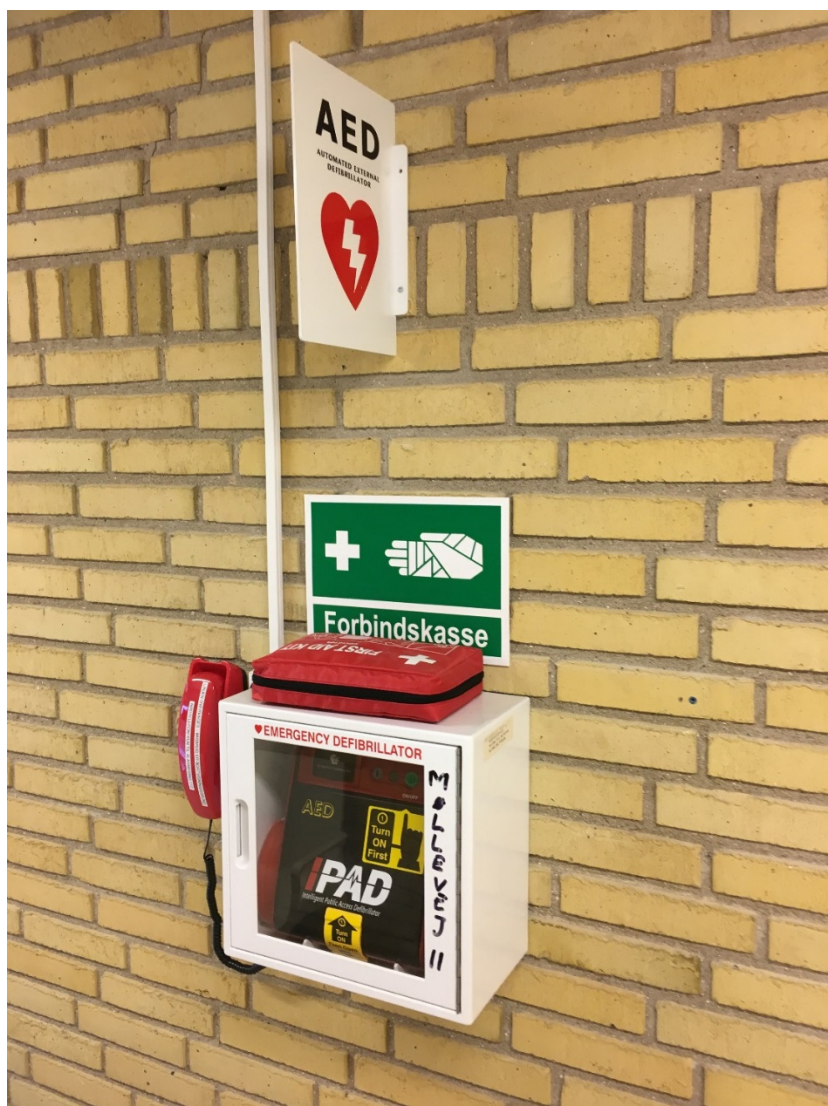
Telefon, AED og forbindingskasse findes i gangarealet mellem bassin og hoveddør
